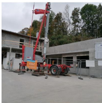
Construction de la mairie de Demi-Quartier
